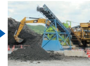
移動式土質改良機 T-SSB にて指定固化材で混練・攪拌
