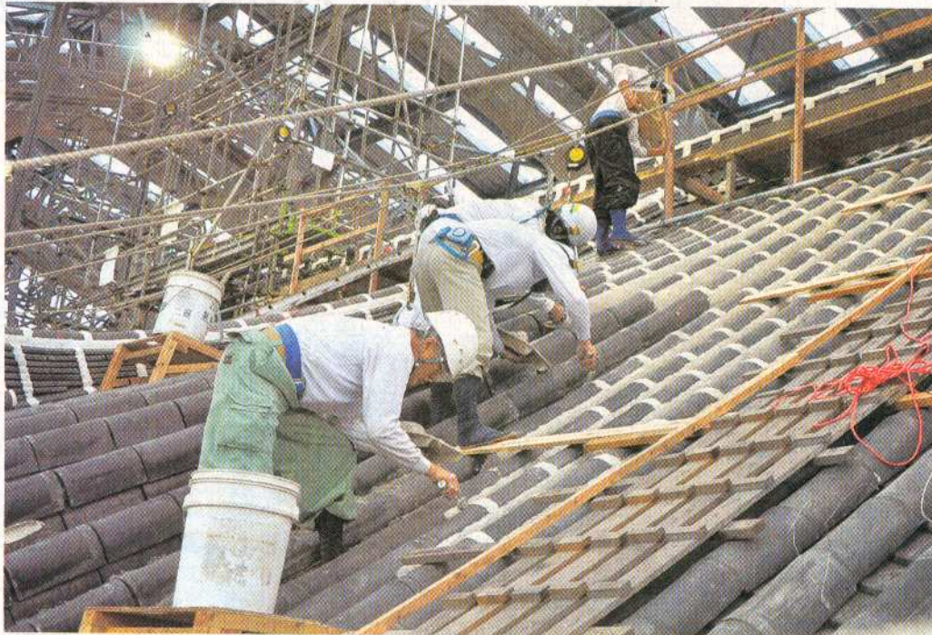
天守閣最上層で続く修復作業。本県産石灰がふんだんに使われている(兵庫県姫路市の姫路城)
